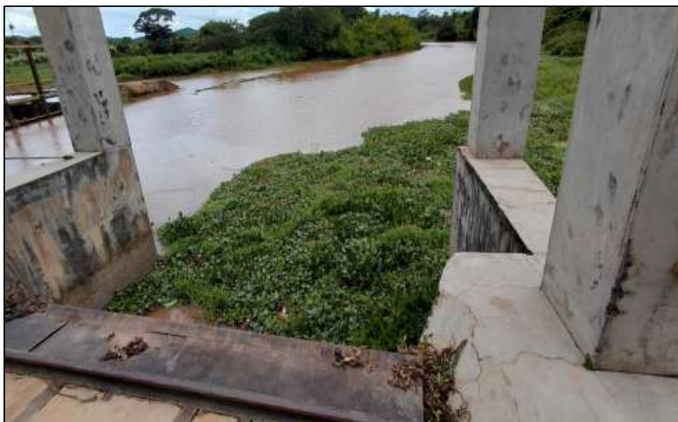
Figura 36 - Presença significativa de vegetação aquática no reservatório, com concentração nas proximidades da tomada d'água da Casa de Força II
