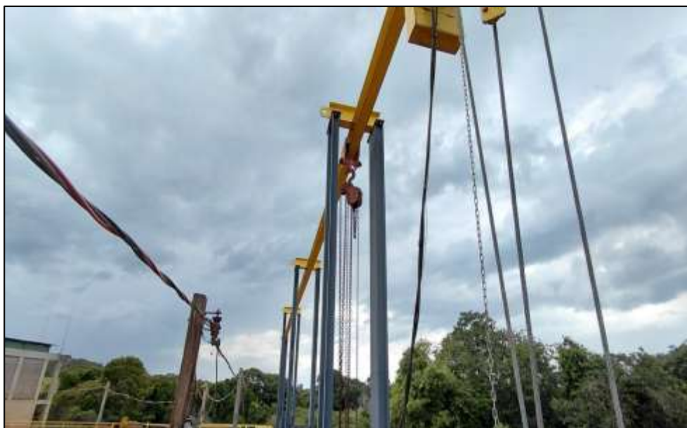
Figura 26 - Sistema de içamento das comportas situadas próxima a Casa de Força I
