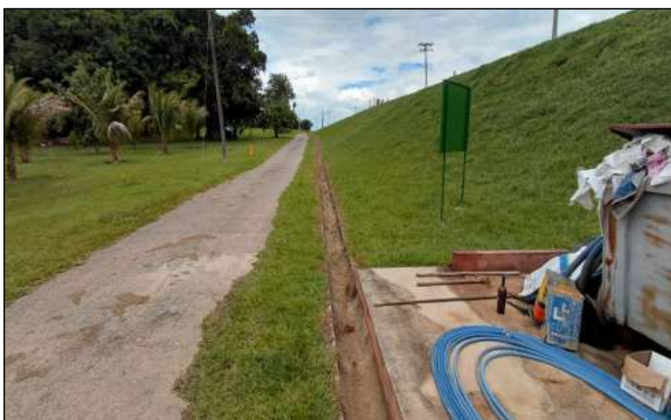
Figura 60 - Barragem de terra, margem direita, paramento de jusante, com indicação da área anteriormente afetada por cupinzeiros e que se encontra com tratamento executado, sem evidências de reincidência no momento da vistoria
