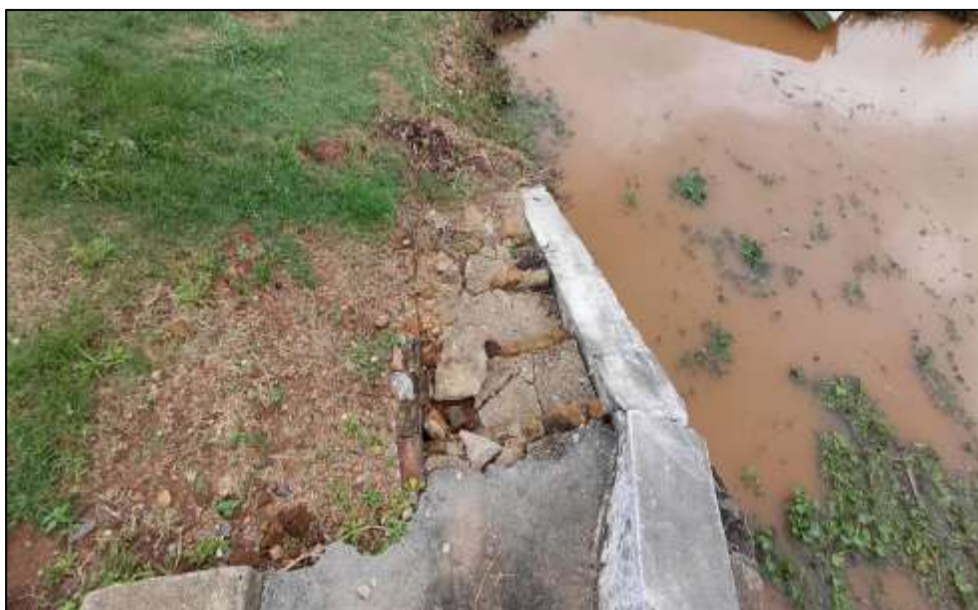
Figura 51 - Detalhe da escada de acesso na Casa de Força I, evidenciando patamar com ruptura e deslocamentos, além de ausência de guarda-corpo no trecho de circulação, configurando condição inadequada para acesso seguro
