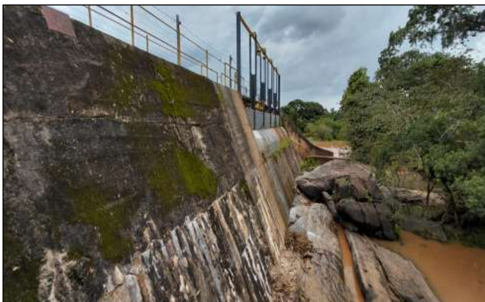
Figura 31 - Infiltrações no segmento da barragem próximo a Casa de Força I.
