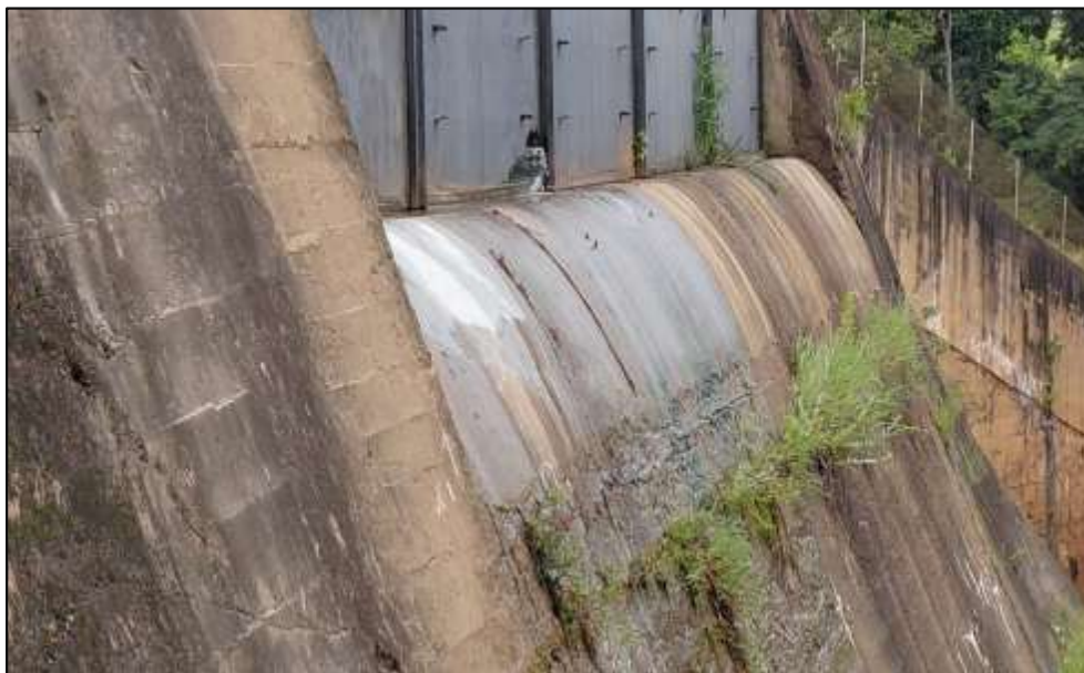
Figura 59 - Vertedouro da PCH Cachoeira do Lavrinha, com registro do trecho nas proximidades da Casa de Força I onde foi executada a correção de deslocamento no concreto, conforme ação corretiva prevista no ciclo anterior
