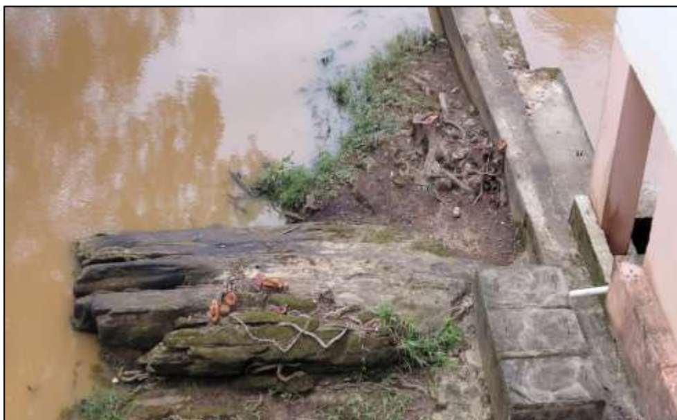
Figura 62 - Área nas proximidades da Casa de Força I e do canal de restituição após remoção de vegetação de porte arbóreo identificada na ISR do ciclo anterior, evidenciando a execução da medida corretiva recomendada
