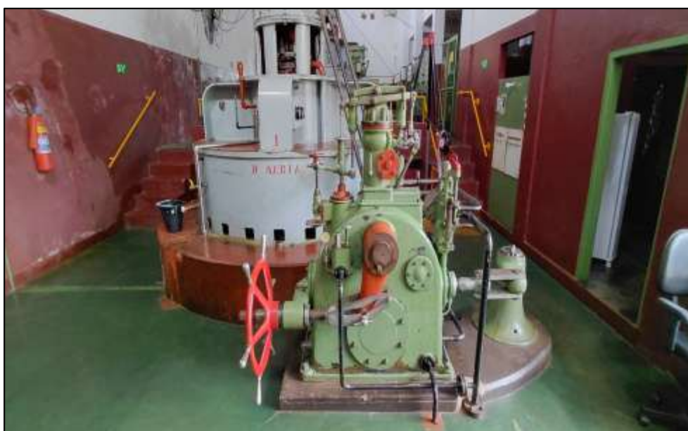
Figura 58 - Regulador de velocidade da Unidade Geradora 1
