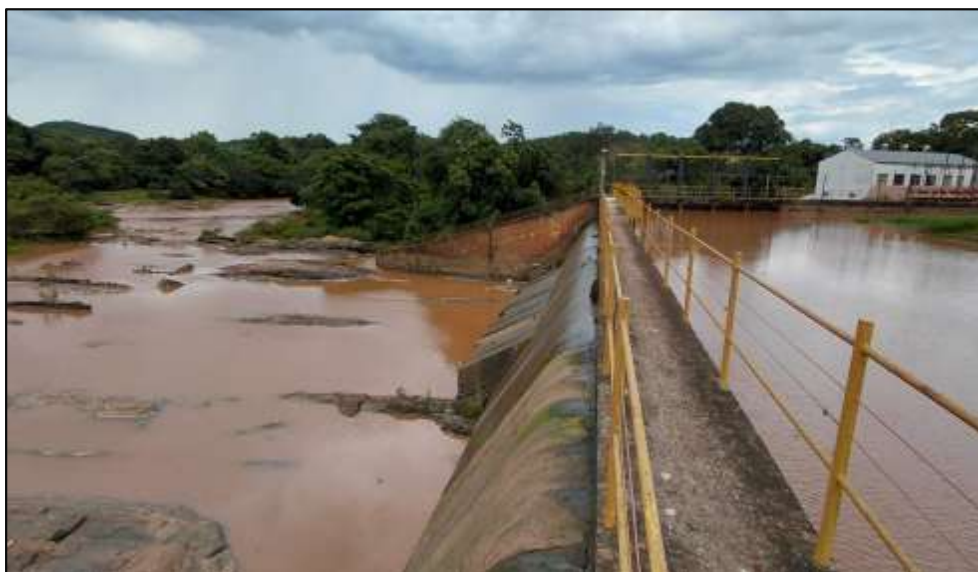
Figura 28 - Passarela de concreto sobre seção da barragem
