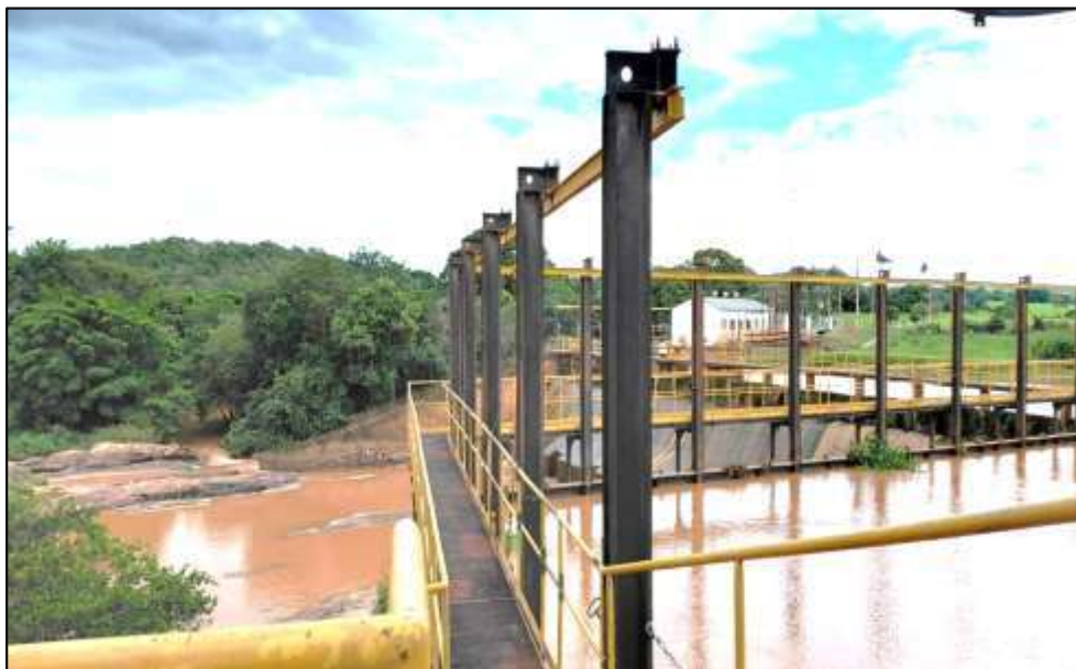
Figura 27 - Sistema de içamento manual das comportas situadas próxima a Casa de Força II
