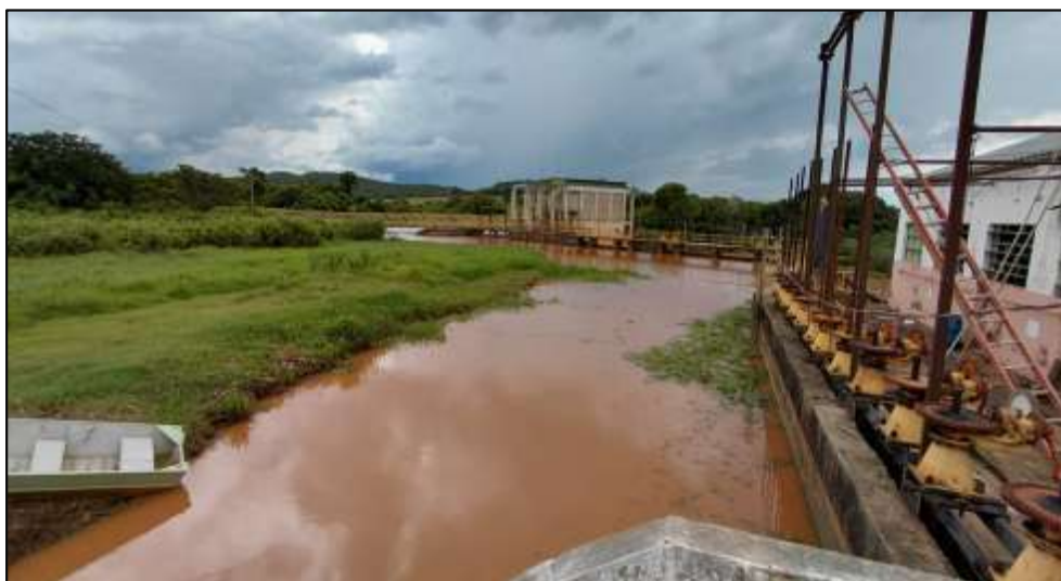
Figura 37 - Tomada d'água associada a Casa de Força I
