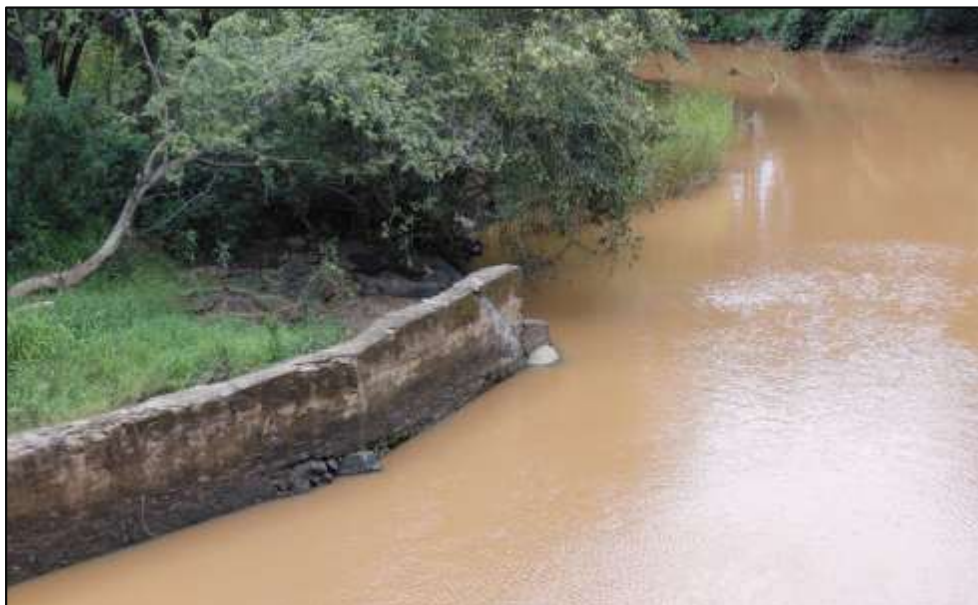
Figura 61 - Canal de retorno (canal de fuga) da Casa de Força I, com registro do muro lateral após correção de rachadura anteriormente identificada, evidenciando a execução da ação corretiva e restabelecimento da condição superficial do elemento
