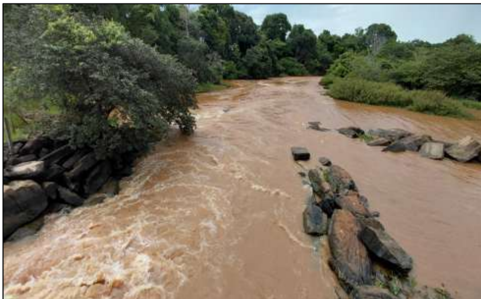
Figura 41 - Canal de fuga associado a Casa de Força II, construído em enrocamento
