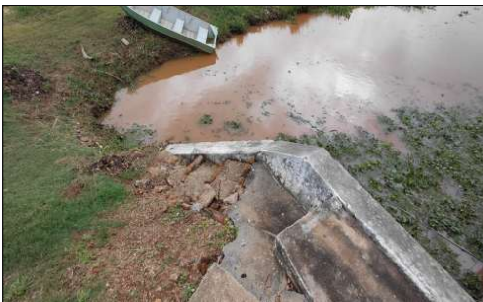
Figura 50 - Vista geral da escada de acesso na Casa de Força I, com degradação de patamares e degraus (elementos fraturados e desagregados), caracterizando perda de integridade e necessidade de reforma
